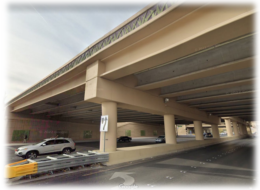
Precast Girders - Project NEON (Las Vegas)
