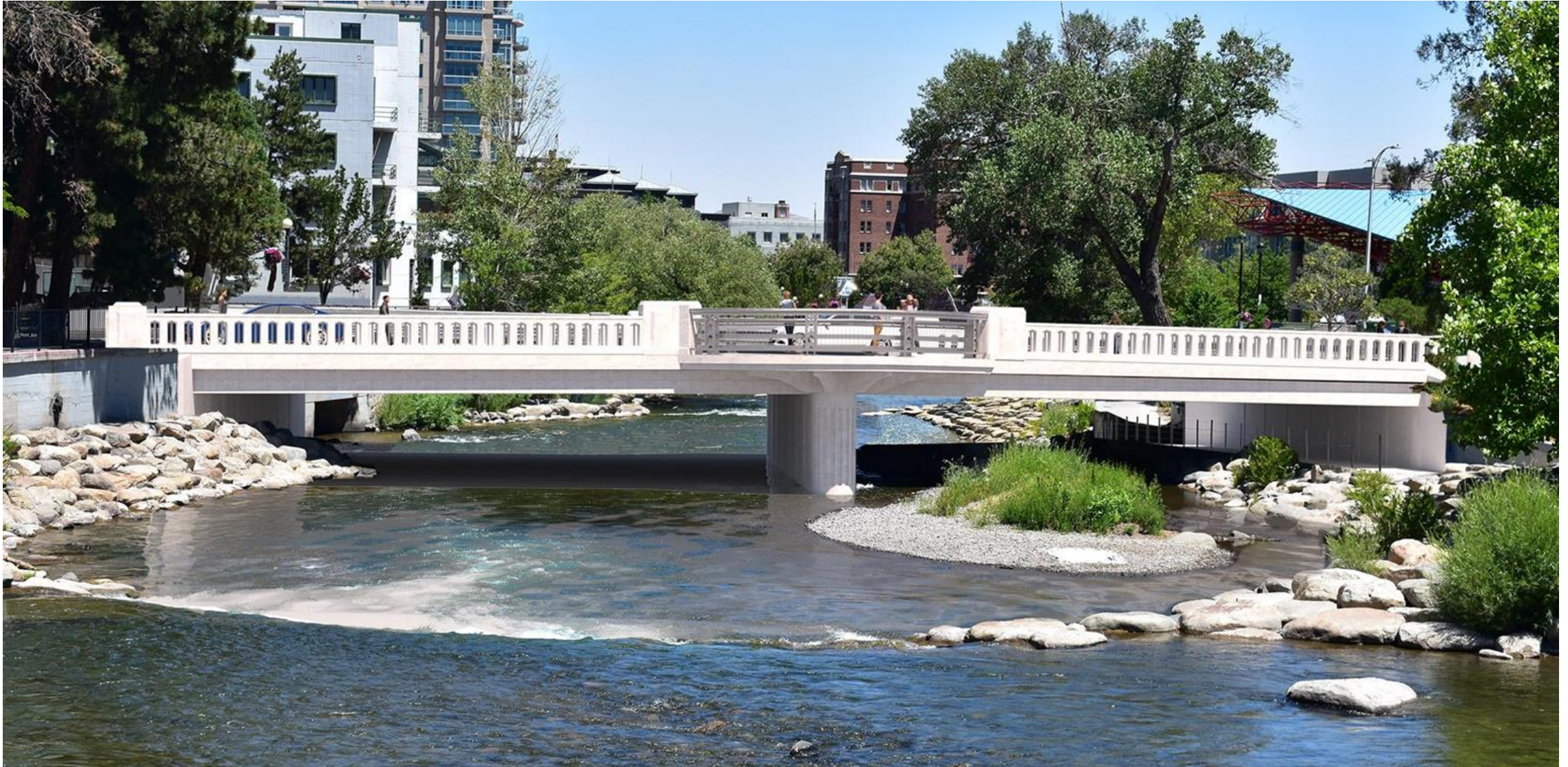
Opción 3 - Barandilla de concreto con valla de metal para la sección del mirador
